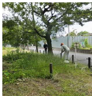
H地区ロープ補修
