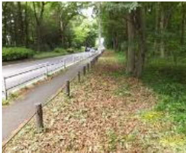
E地区ゴルフ場側作業後
