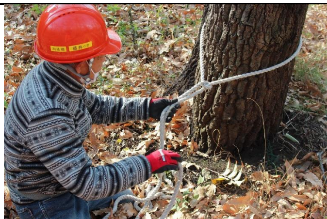
八の字結び(エイトノット)で倒木方向を制する
